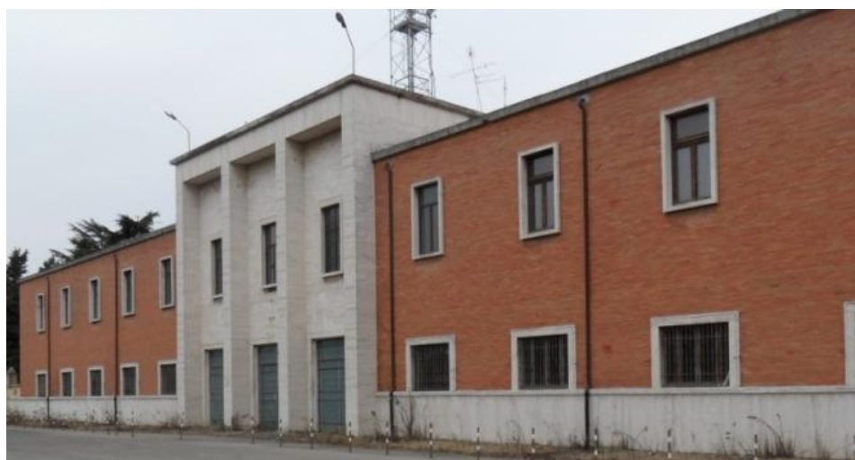
La palazzina all'ingresso della caserma. Il resto degli edifici si sviluppa ad un piano.
